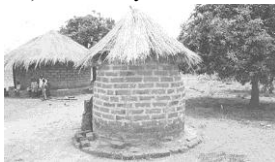
c) Tahıl daneleri için kullanılan duvar tipi bir silo (Shepherd, 1999)
