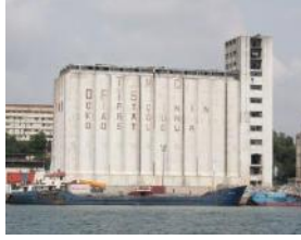
a) TMO'ya ait betonarme bir tahıl silosu
